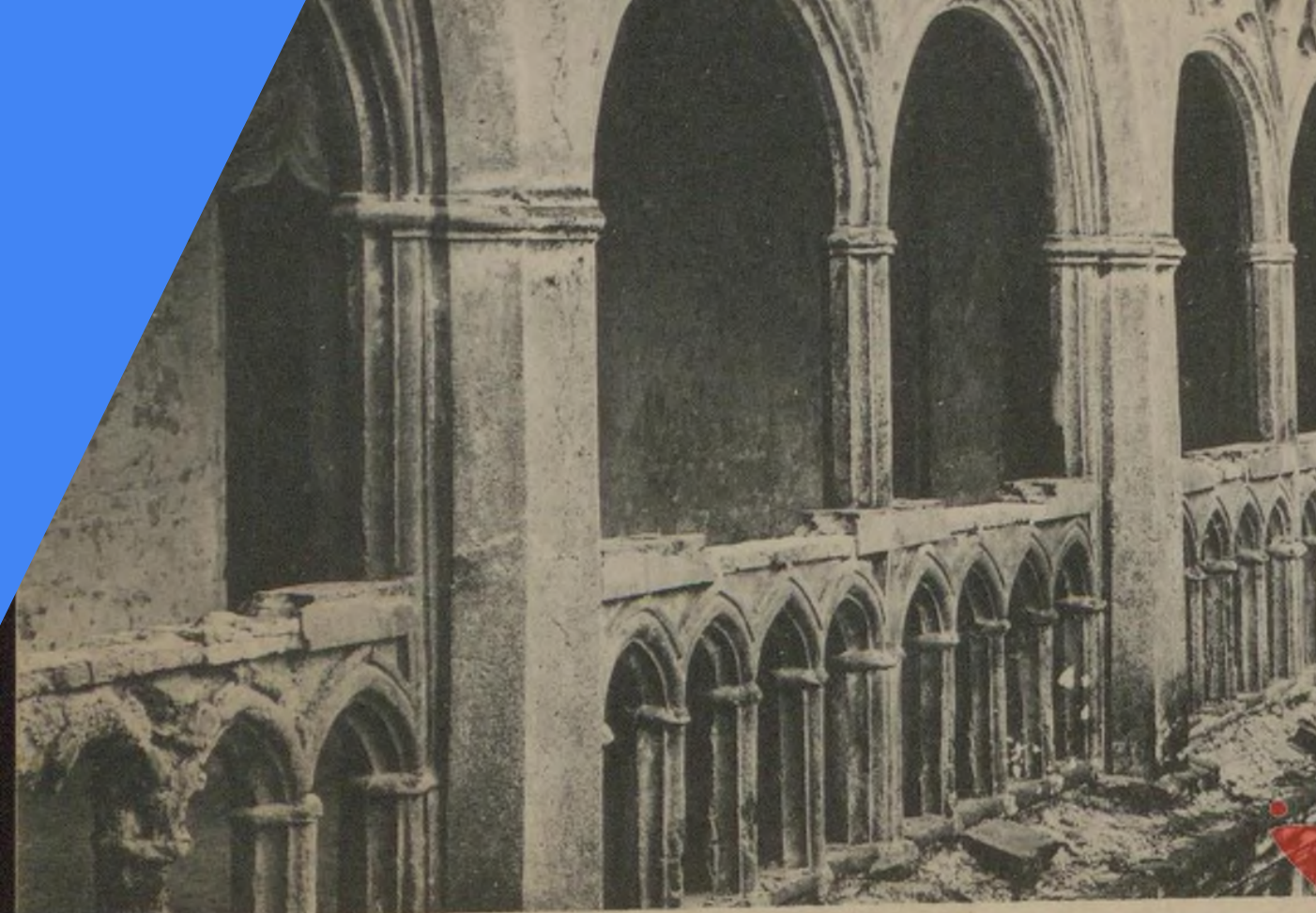
Monasterio de Guadalupe.- Claustro de las Enfermerías. Siglo XVI. Galería n
